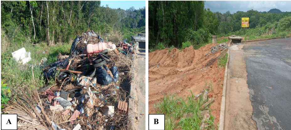
Figura 3 – (A) Resíduos sólidos descartados próximo a área de (APP) (B) Remoção dos resíduos sólidos com implantação de placas de orientação aos moradores.
