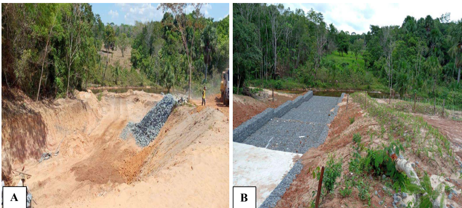
Figura 5 – (A) Início da obra de contenção do processo erosivo (B) Finalização da obra e plantio de capim no entorno da estrutura para ajudar a estabilizar o sedimento.
